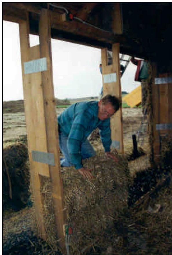
Billede 16 - halmballe nr. 2 presses på plads mellem "stigerne" 23
