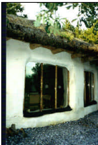
Billede 29 - Sydfacaden. Såløbænkene er overflade-beskyttede med linolie 38
