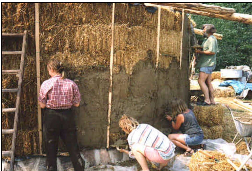
Billede 10 - Første lag lerpuds lægges på. Det kan anbefales at dække kæppene med armeringsvæv, således at pudset arbejder med vævet, og ikke med kæppen. Kæppene er forbundet med en tilsvarende kæp på indersiden, og det med en strik imellem hvert skift baller 13
