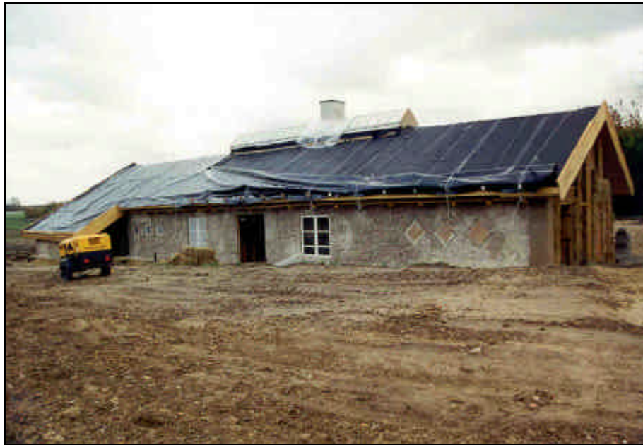
Tegning 10 - den ene langside med første lag kalkpuds. Taget mangler endnu de løse muslingeskaller 22
