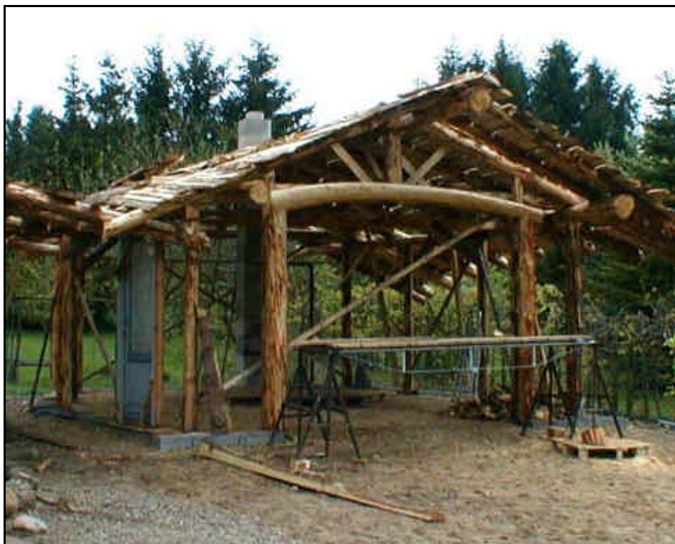
Billede 11 - Den bærende konstruktion. Døren til venstre er fæstnet. Sammenføjning til hus anes 15
