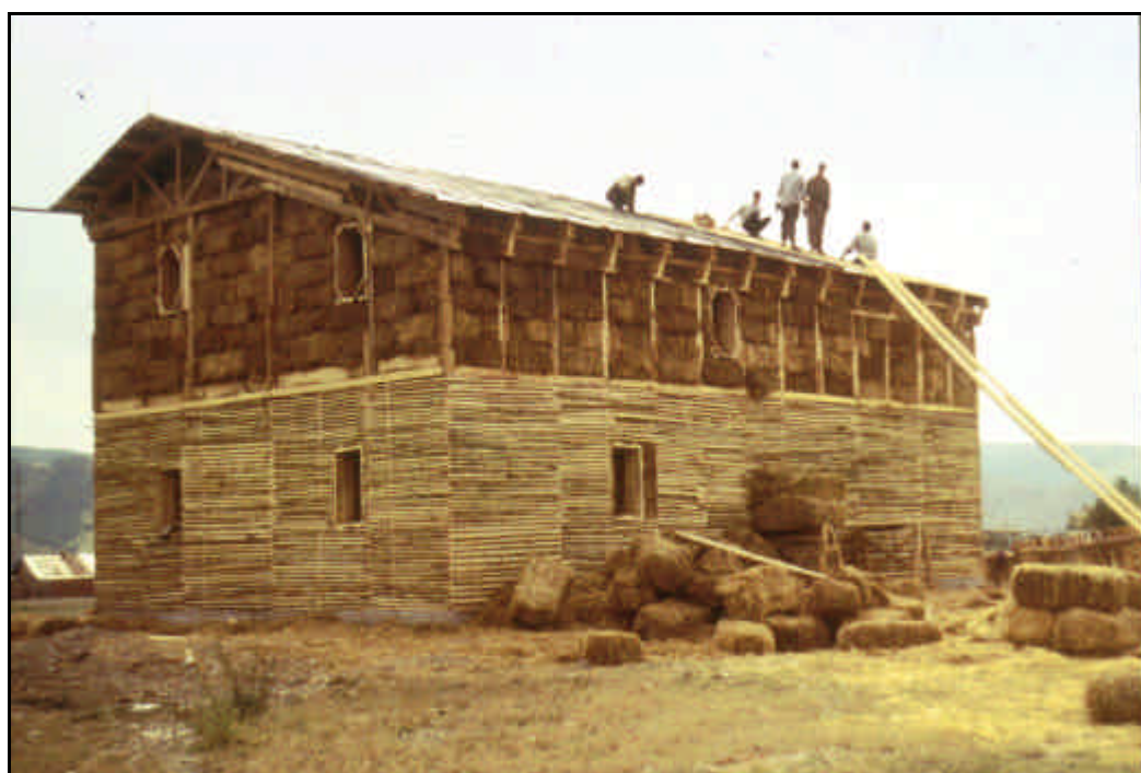
Billede 37 - Sundhedsklinik i to etager. Første etage er forberedt til pudsning 48
