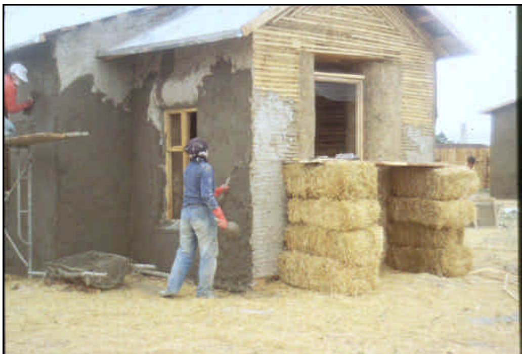
Billede 38 - Puds påføres, efter væggen er beklædt med lister 49
