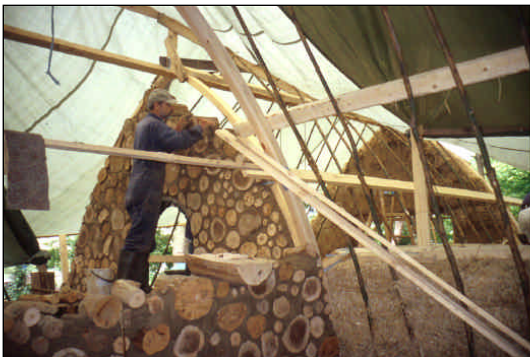
Billede 33 - Vægge af brændestykker og lermørtel, såkaldte knudevægge, er på 44
