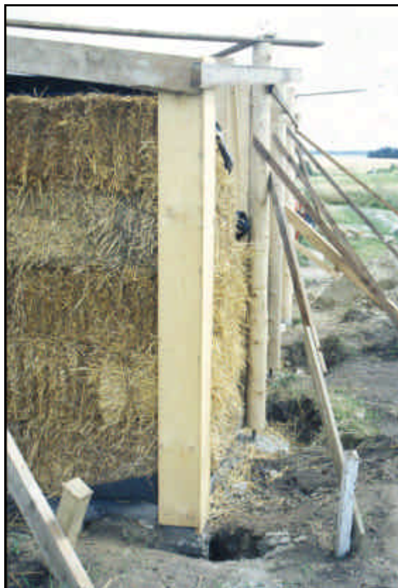
Billede 7 - Hjørnet er fikseret, så man ikke i iveren bygger den ujævn 11
