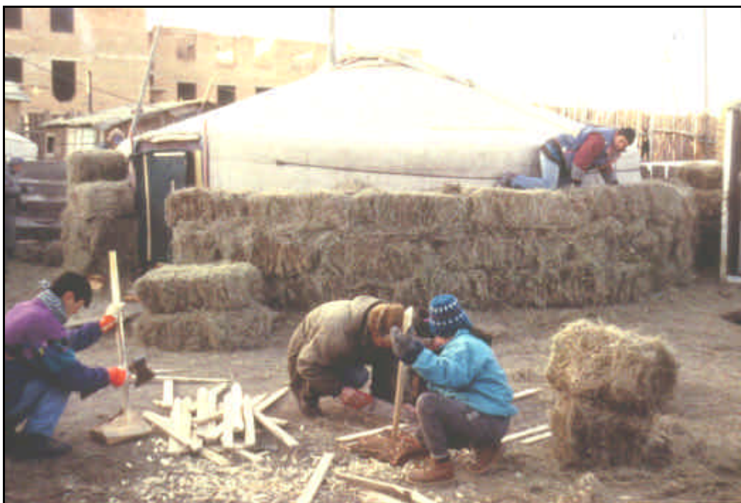
Billede 35 - En Geer efter-isoleres med halmballer 46
