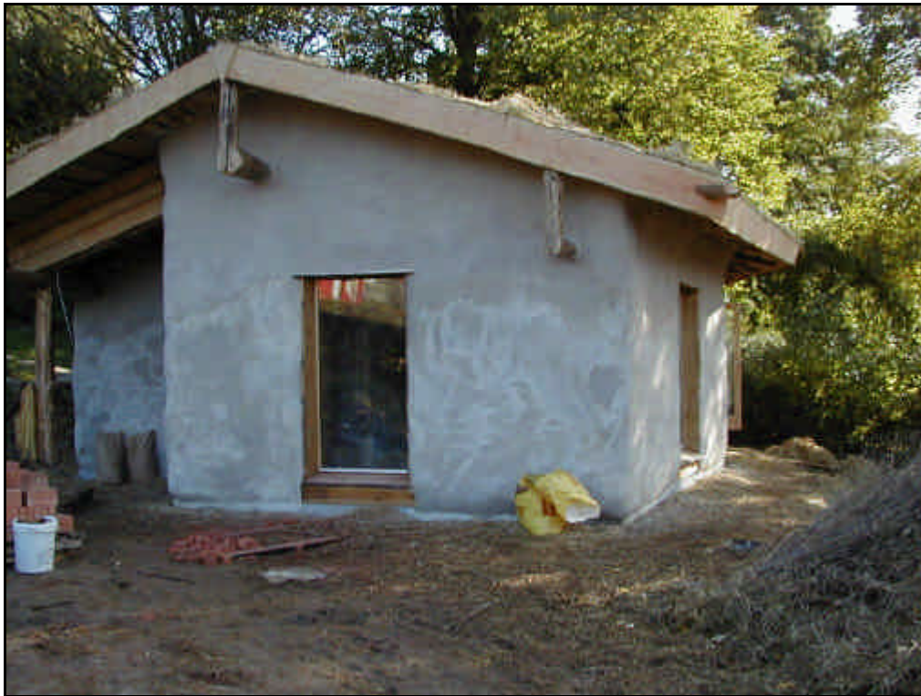
Billede 27 - Bemærk at spærene ikke gennembryder den kalkpudsede halmvæg. Det er kun remmene, der går igennem væggen 36
