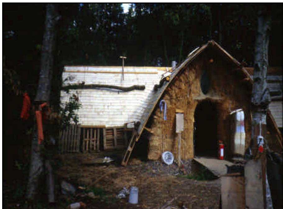
Billede 30 - På taget slås aspe-spån op 41
