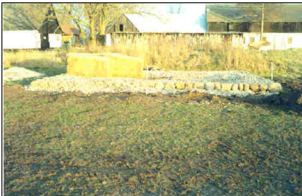
Billede 18 - Syldstenene ligger på deres pladser, og halmen kan komme på banen 25
