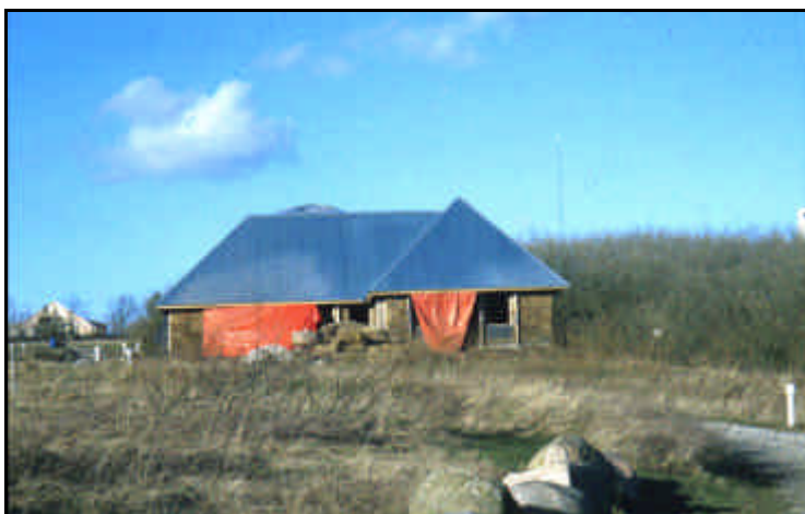
Billede 3 - Set fra syd-skråningen, inden tagrenderne er monteret kalk-pudsen er på 7
