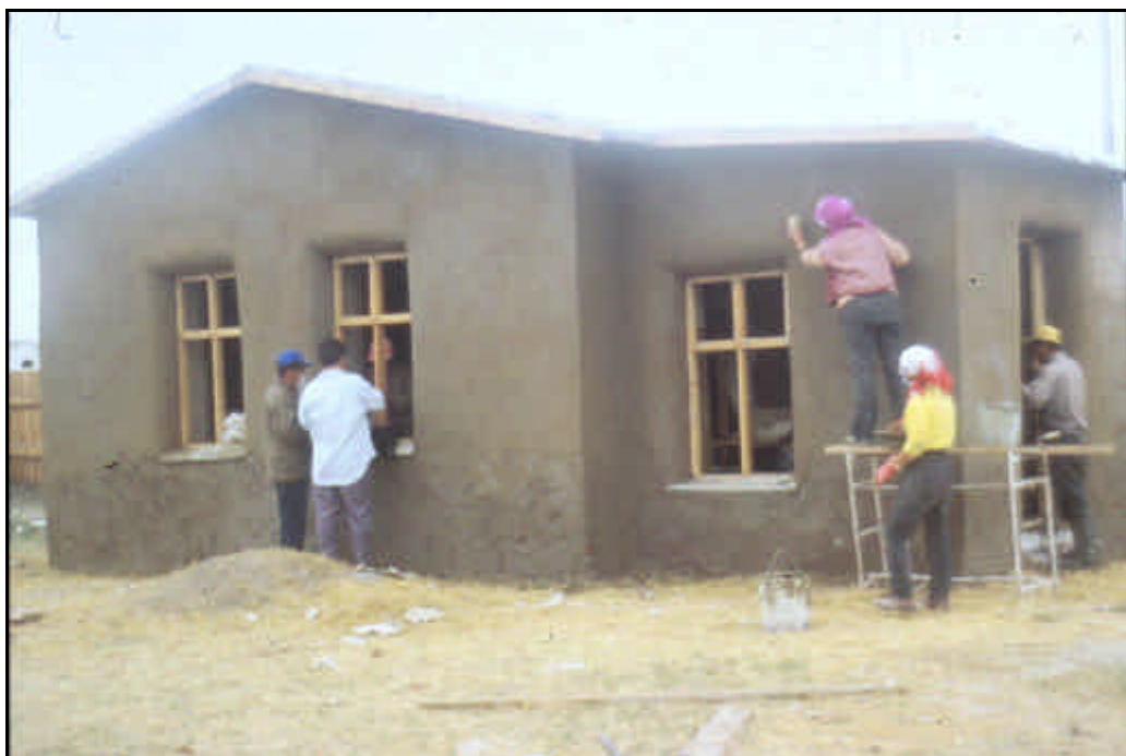
Billede 39 - Pudsarbejdet er ved at være færdigt 50
