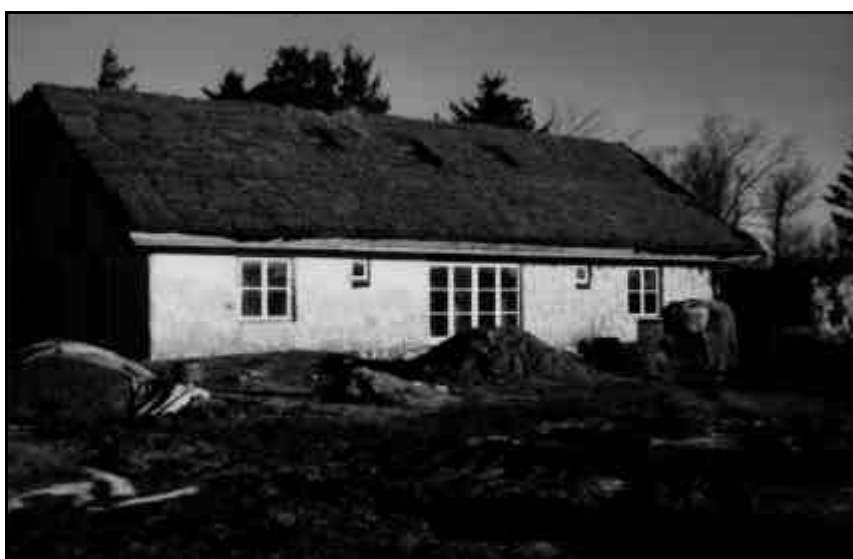
Billede 1 - Sydgavlen, med ovenlys-vinduer i vækst-laget. Pudslaget påført væggen 4
