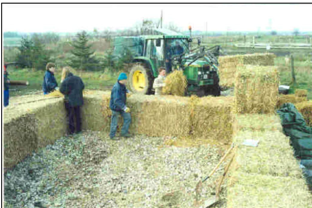
Billede 19 - Første skift minibigballer er lagt på plads, med hjælp fra frontløfteren 26
