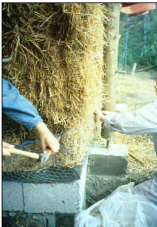
Billede 5 - På billedet ovenfor bukkes sokkelpappet op, og danner derved et lille badekar i bunden af halmvæggen 9
