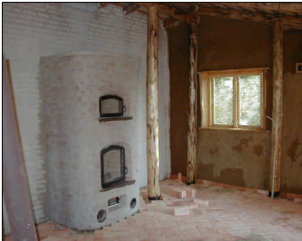
Billede 28 - Den finske masseovn, der både leverer varme, varmt vand, nybagt brød og levende ild 37
