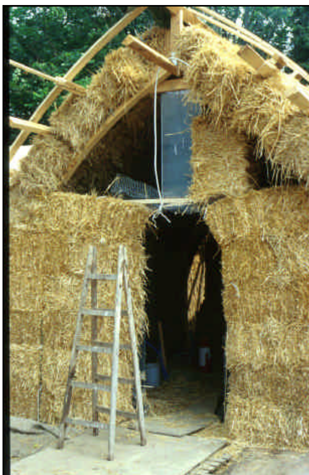
Billede 31 - Gavltoppen over entreen er under opbygning 42
