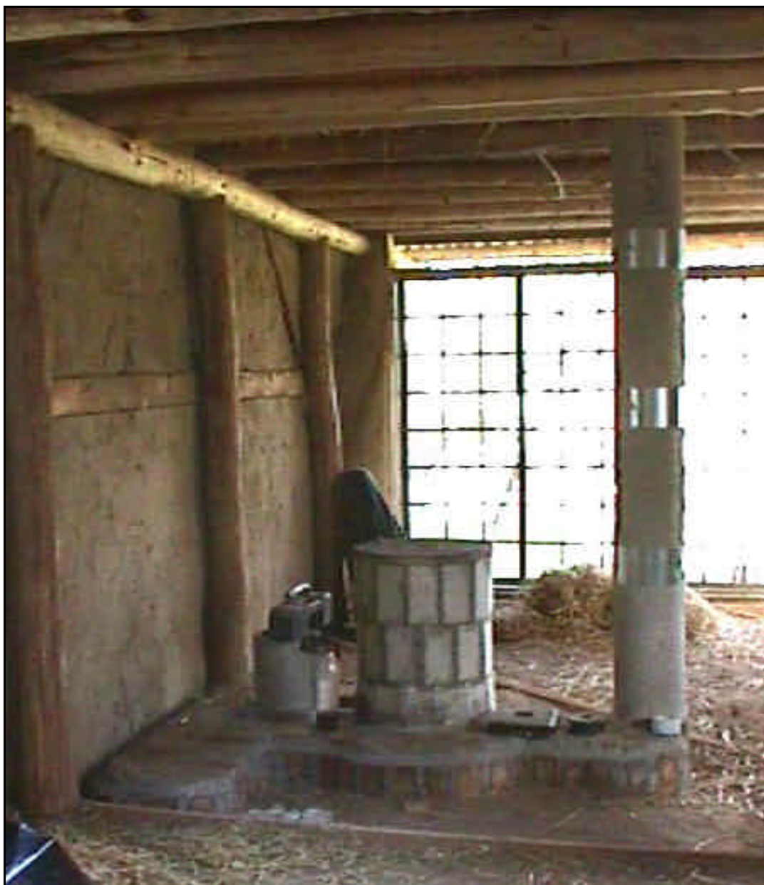
Billede 24 - Flexovnen samt den bærende konstruktion 31
