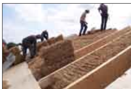
Abbildung 10 Strohballeneinbau/Dach
