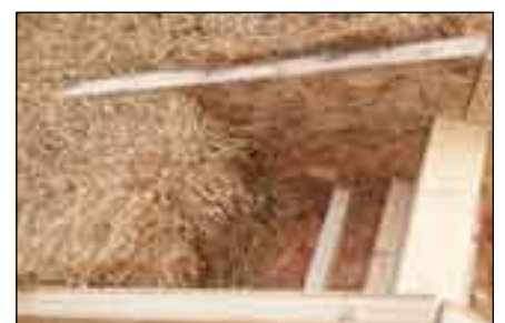
Abb. 11 SB zwischen Kastenträgern
