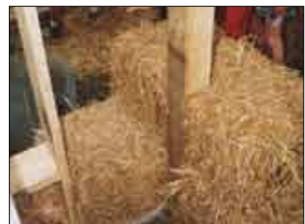
Abbildung 9 Strohballeneinbau
