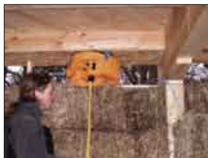
Abbildung 8 Wandkomprimierung
