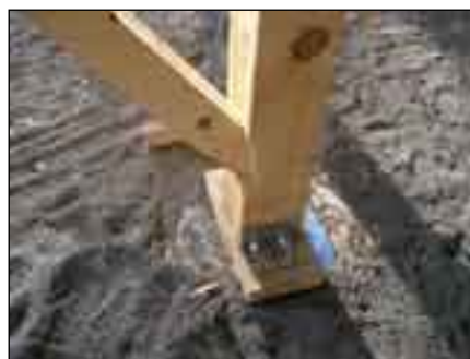
Abbildung 6 Strebenanschluss
