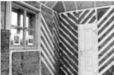
Strohtec-Wand: Fenster und Türen können problemlos eingesetzt werden, da die Strohbälle der Länge nach leicht zu teilen sind.
